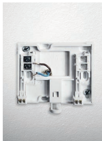
Étape 1 : Retirer la base fixée au mur
